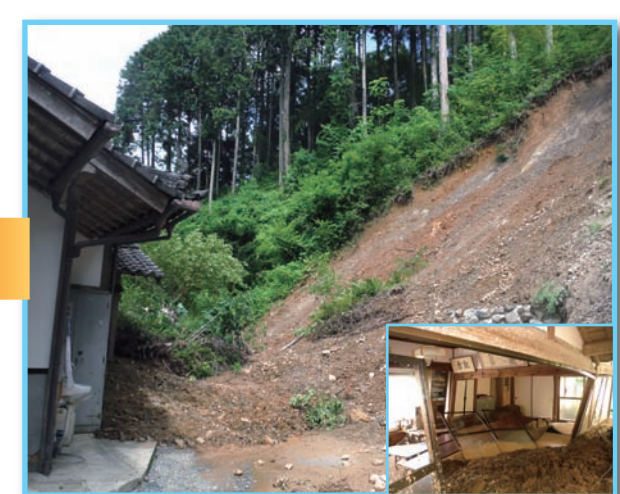
高梁支所管内神社 (高梁市内) 土砂流入・建物共済加入
